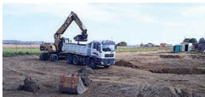
Prva dela na gradbišču - izkop za novo POŠ Marjeta ...
